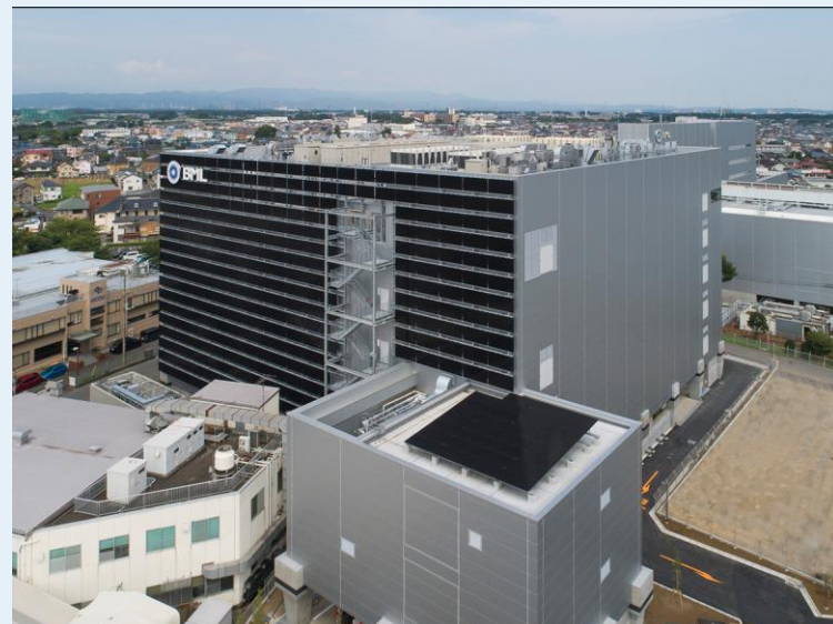
＜南側側壁 太陽光パネル＞
