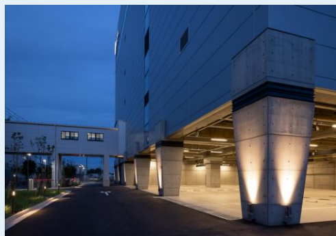
＜1階部分はピロティ＞
