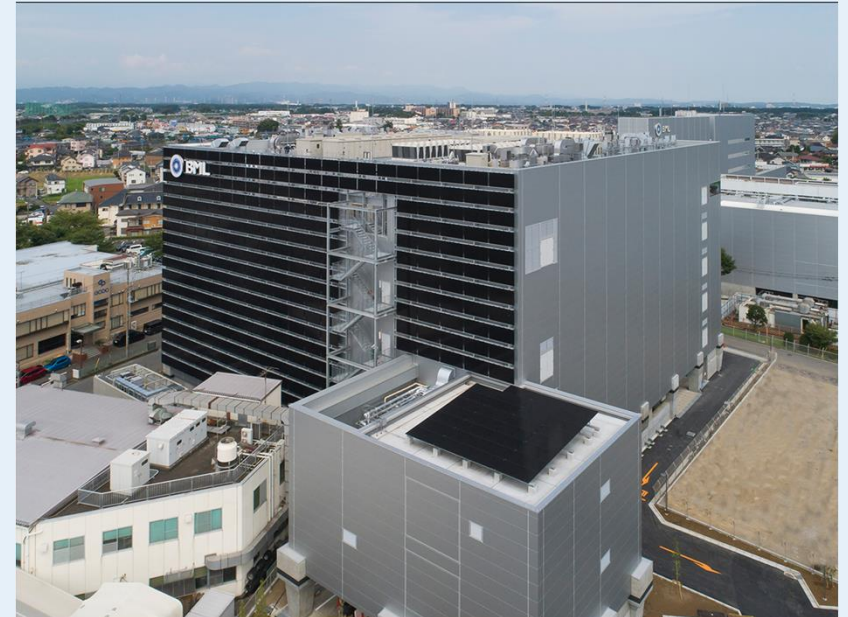
<南側側壁 太陽光パネル>
