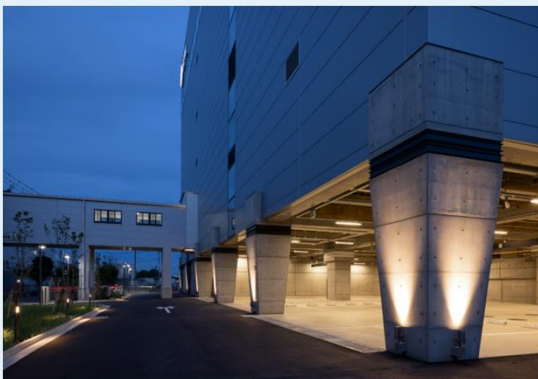
<1階部分はピロティ>
