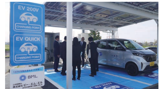
EVステーション
